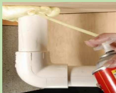
Applicazione di schiuma poliuretano
